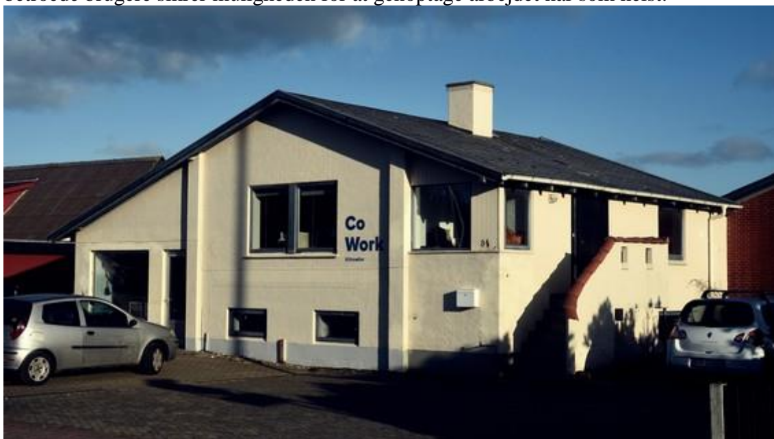
Figur 4.1: Cowork Klitmøller er indrettet i denne ejendom på Ørhagevej (Foto: Jens Kaae Fisker)
