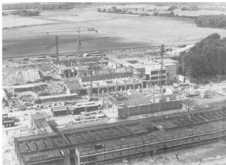
Dette luftfoto af Campusbyggeriet, taget et par år efter byggestart, giver et godt indtryk af byggeriets komplicerede karakter og vidner samtidig om de store mængder beton, der gik til. I baggrunden bag markerne skimtes de hvide elementbygninger foran H.C. Ørsted Kollegiets massive murmasser. (Foto: Arne Bloch).
