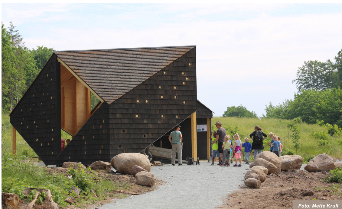
Abent hus i Pipstorn
