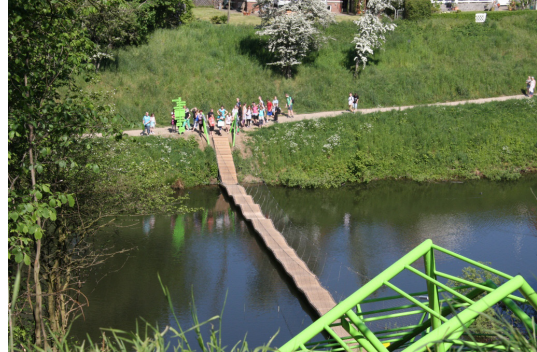
Stormbroen, der fører til Dronnings Bastion
