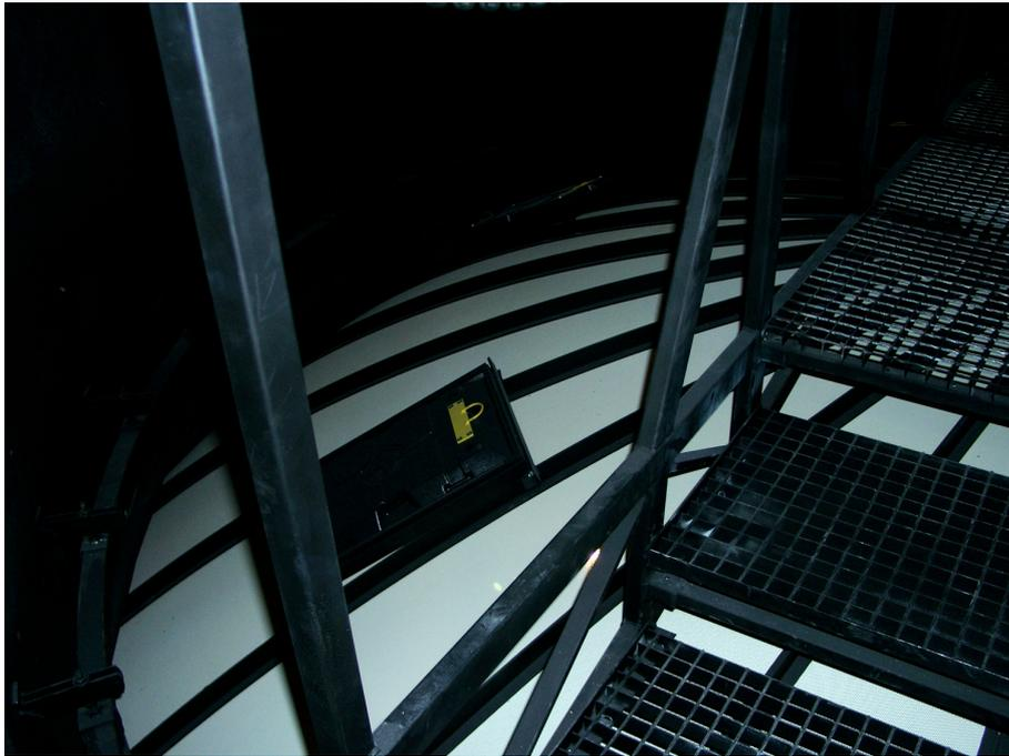
Abbildung 2.1: Kuppelkonstruktion des Mediendoms Kiel, Rückseite der Projektionsfläche, deutlich sind die matt schwarz lackierten Elemente zu sehen, die die Projektionsfläche halten. Ebenfalls im Bild: einer der Flachpanel-Lautsprecher.
