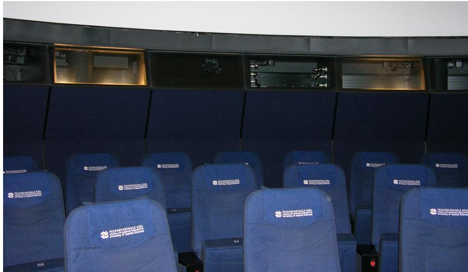
Abbildung 6.3: Sitze und Projektornischen im Mediendom Kiel. Deutlich ist eine fast vollständig verkleidete Nische zu erkennen, die einen der sechs Projektoren beinhaltet. Der obere helle Bildrand ist die Projektionsfläche.
