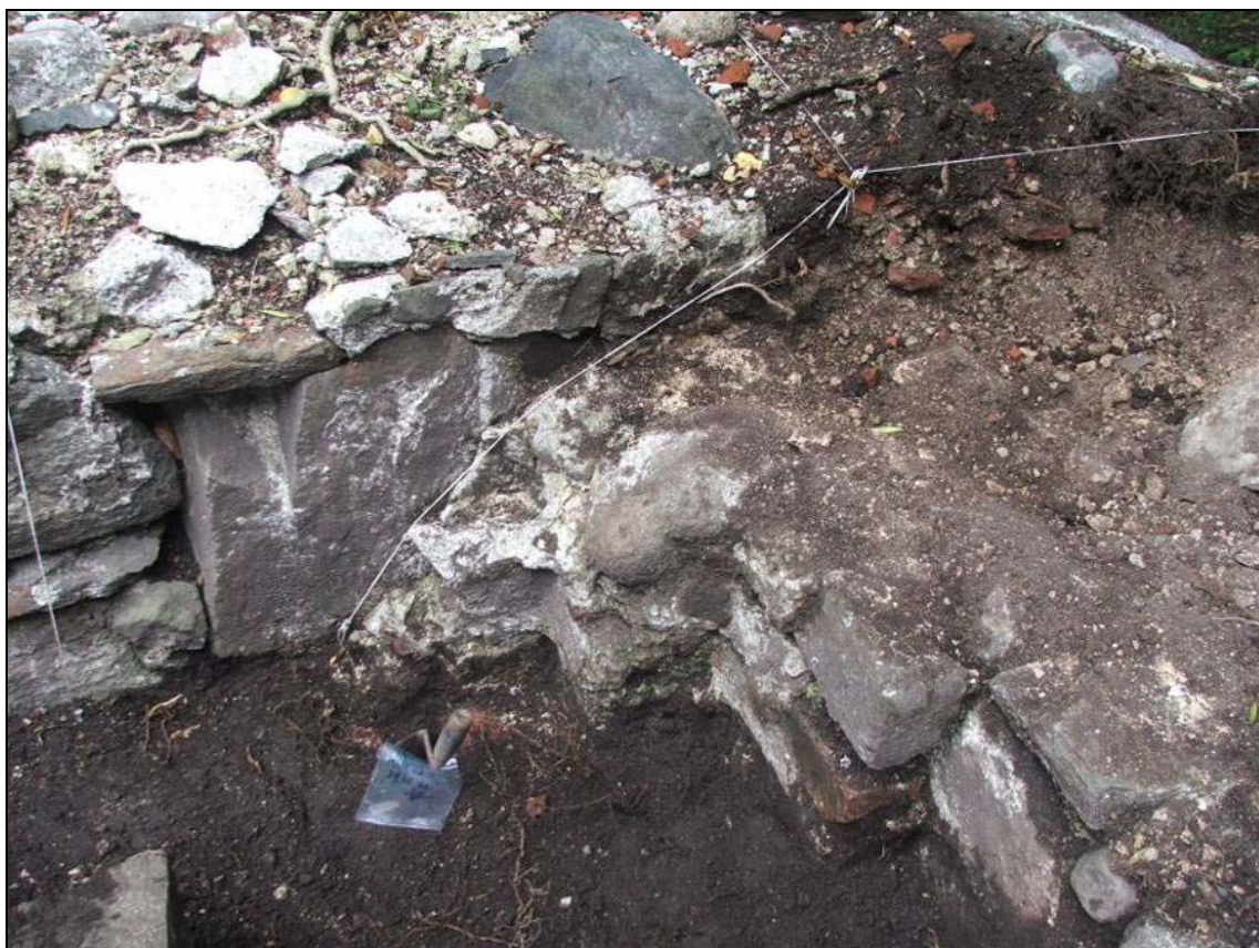
Fig. 9. Det sydöstra hörnet av klosterkyrkan i Varne vid undersökningen sommaren 2008. Murkärnan med det medeltida murbruket håller på att rensas fram. I hörnet syns resterna från ett av de sekundära valvfundamenten. Foto Christer Carlsson.
