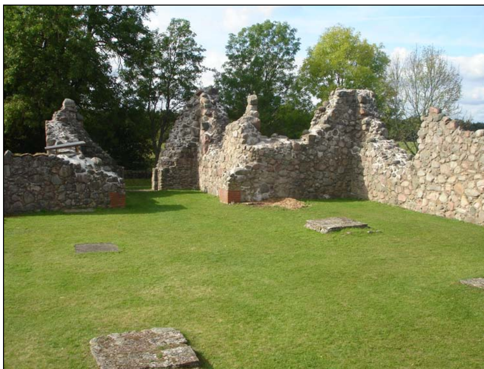
Fig. 17. Ruinen efter Kronobäck klosterkyrka mot väster. De tjocka murarna är uppförda i gråsten med endast ett fåtal detaljer av tegel. De kraftiga fundamenten till valvpelarna är väl synliga. Foto Christer Carlsson.
