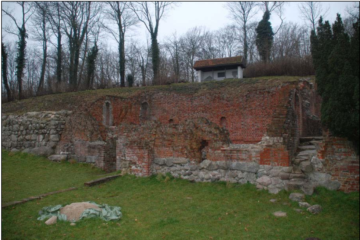
Fig. 4. Ruinerna av det romanska 1200-talshuset i Antvorskov kloster. Fotot är taget från söder och visar byggnaden vilken kan ha använts som bostad, representationslokal och förråd. Foto Christer Carlsson.
