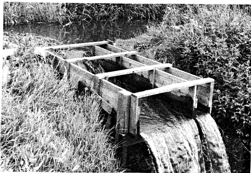
Figur 7. Foto af vandfordelingssystem ved Store Skjernå Kanal, Vestre bikanal ved Sdr. Felding. Den smalleste af tudene er ca. 15 cm bred. Den brede tud udmåler vand til flere lodsejere på den nedre terrasseflade.
