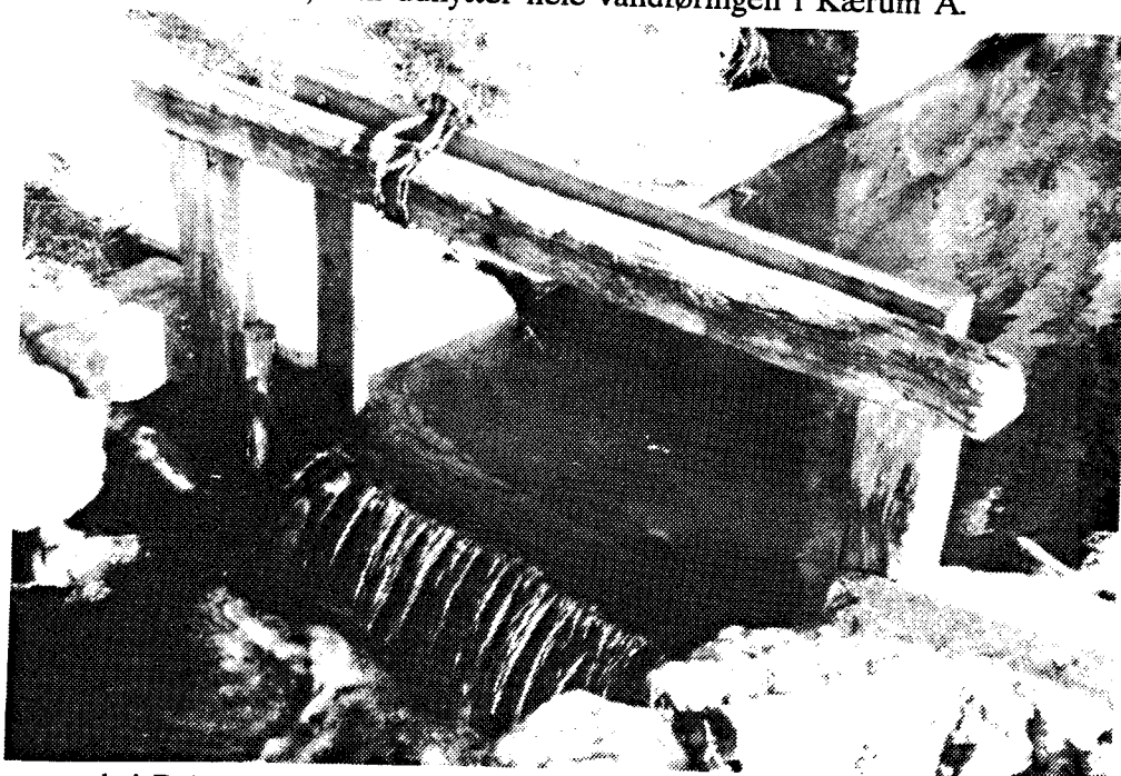
Stemmeværk i Bybækken, Bogense. Stemmeværket stemmer vandet op til en stor dam vest for byen, men har muligvis også fungeret som vaskeplads.
