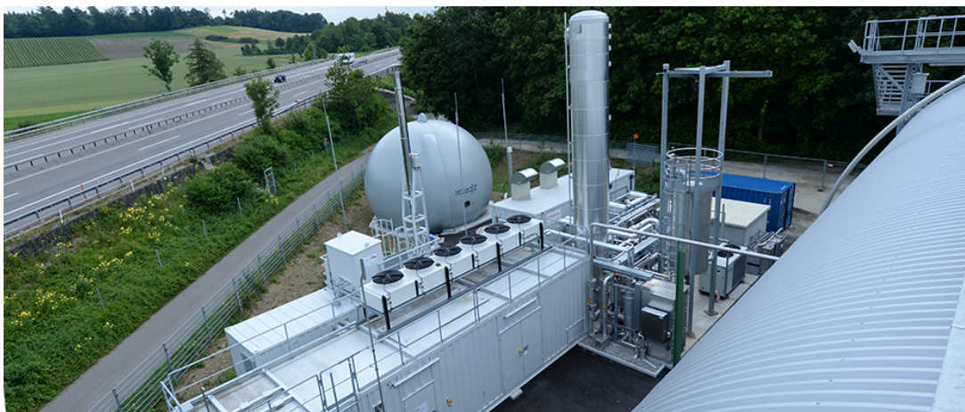
Figur 15: Aminskrubberanlæg produceret sveiziske Hitachi Zosen Inova opsat af det danske firma Nærenergi Danmark [29].
