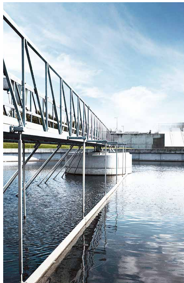
Frekvensomformere kan bidrage markant til at forandre renseanlæg fra energiforbrugere til energiproducenter.
