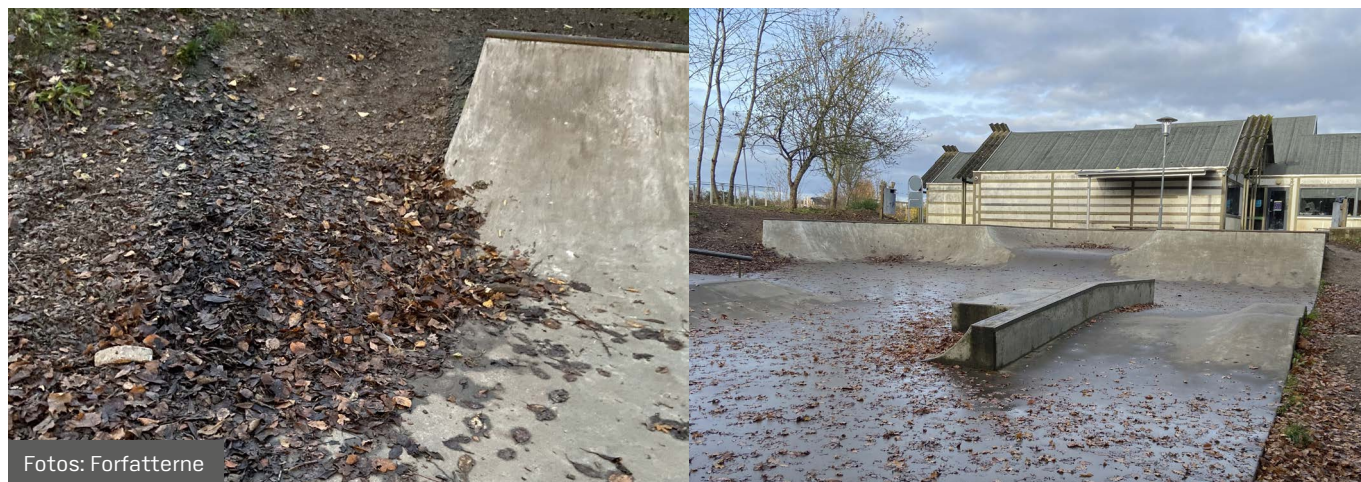
Foto 20 og 21: Nedfald og flis i parken.
