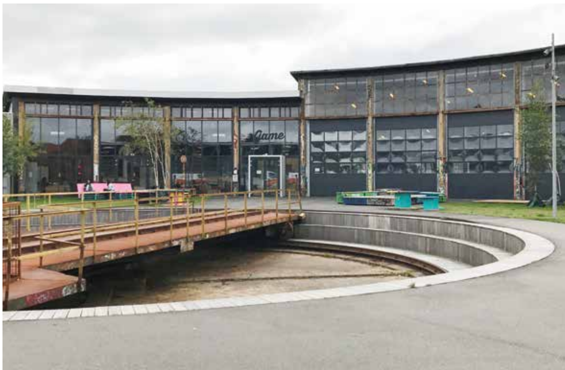
Drejeskiven og de gamle bygninger, GAME Streetmekka Esbjerg.
